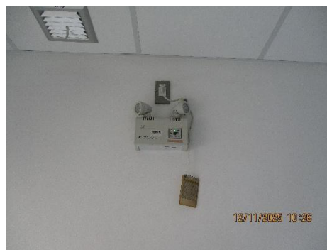
ไฟส่องสว่างฉุกเฉินภายในสำนักงาน
